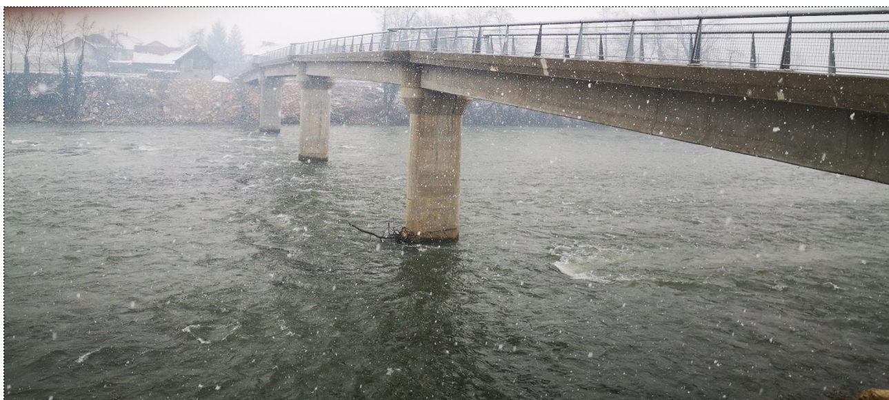
Slika br. 5: Postojeći most u Dolina-Alići (3km od Zavidovića)
