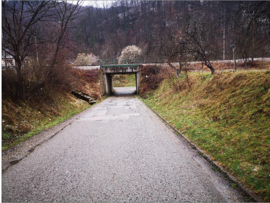
Slika br. 10: Podvožnjak na lokaciji br.4 (4,5x4,0m)
