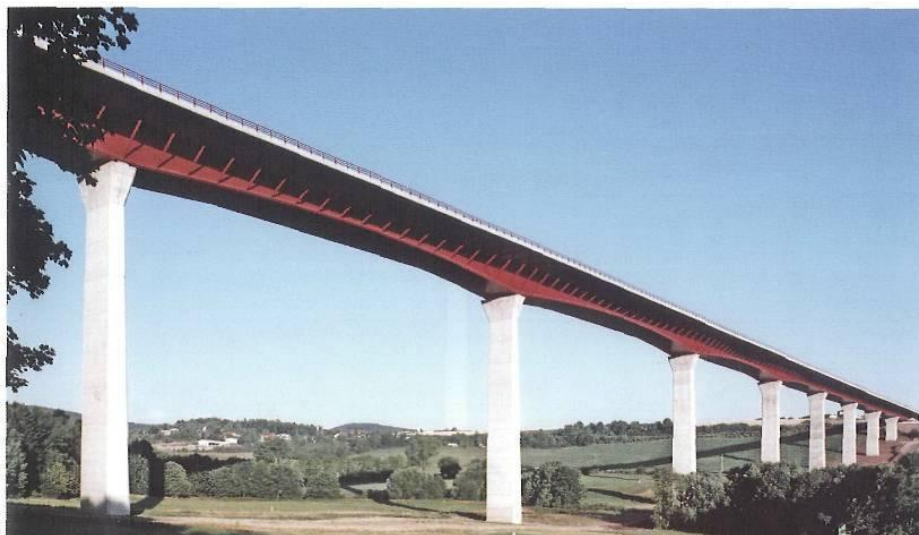
Viadukt Talbrücke Ruchenbach nakon izgradnje
