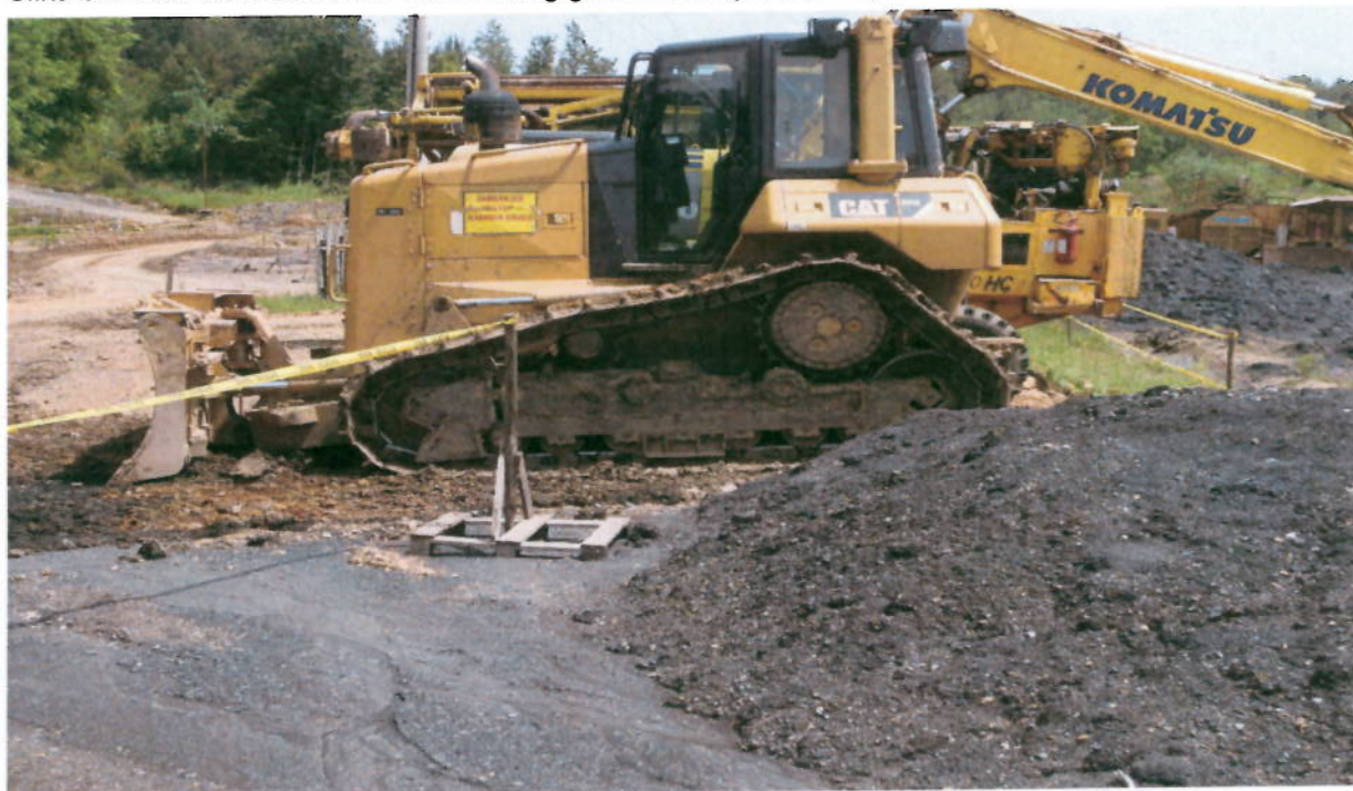
Slika 6.5. Rad buldozera na PK tehničkog građevinskog kamena „Solim“
